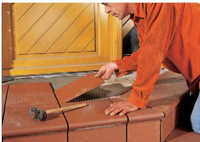
4. FX 900 – укладка плитки
