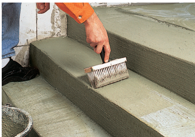
3. MDS – гидроизоляция
