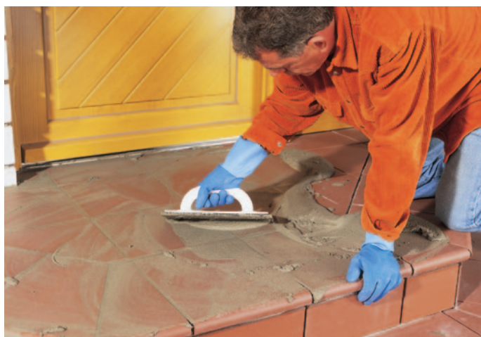
5. FBR 300 – заполнение швов
