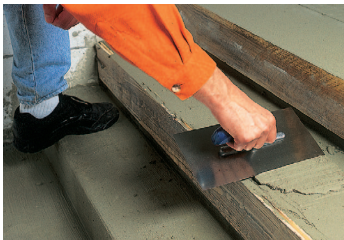
2. BRS – ремонт основания
