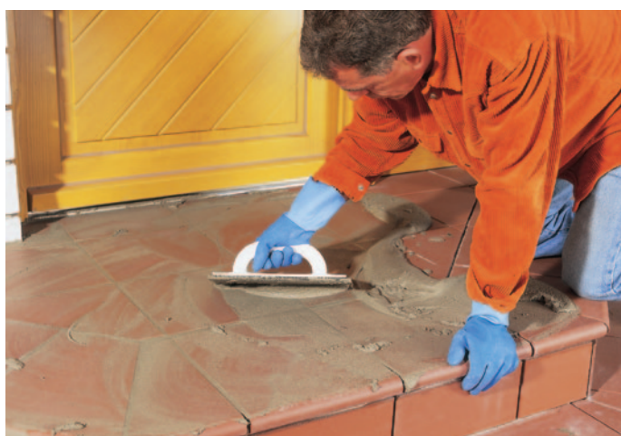
5. FBR 300 – заполнение швов
