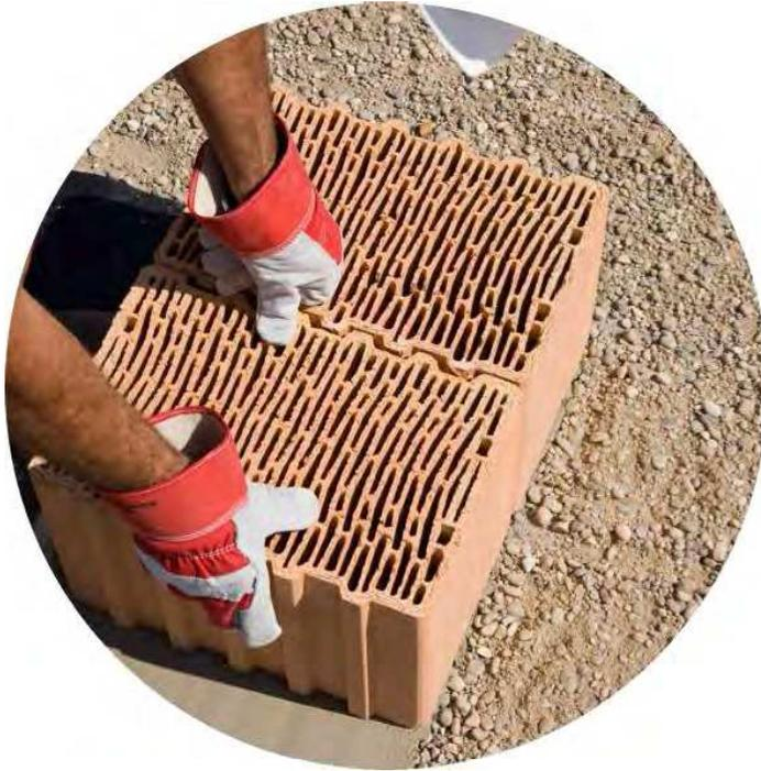
**Porotherm соединяются через «паз-гребень» и не требуют заполнения вертикальных швов раствором**
