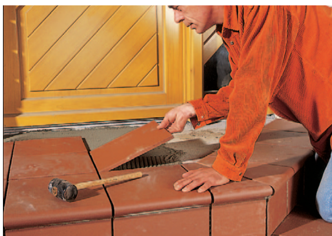
4. FX 900 – укладка плитки
