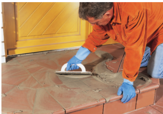
5. FBR 300 – заполнение швов
